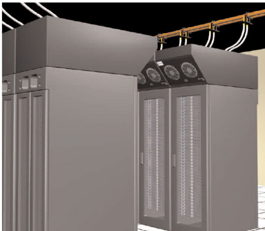
Figura 14. El enfriamiento suplementario permite densidades de bastidores mayores y mejora la eficiencia del enfriamiento.
